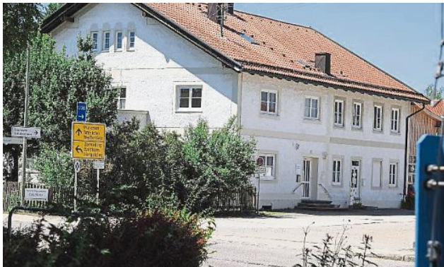
Erbaut in den 1920er-Jahren soll das historische Gebäude saniert werden. FOTO: SRO
